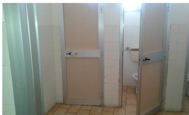
Servizio igienico al piano terra
