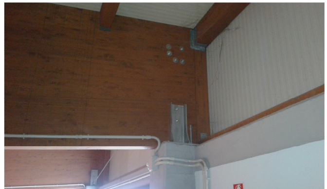
Appoggio delle travi principali su pilastri in c.a. 50x70
