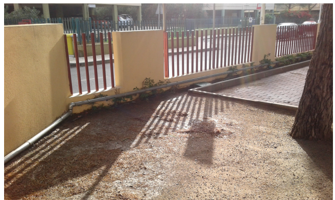
Tratto con tubazione a vista
