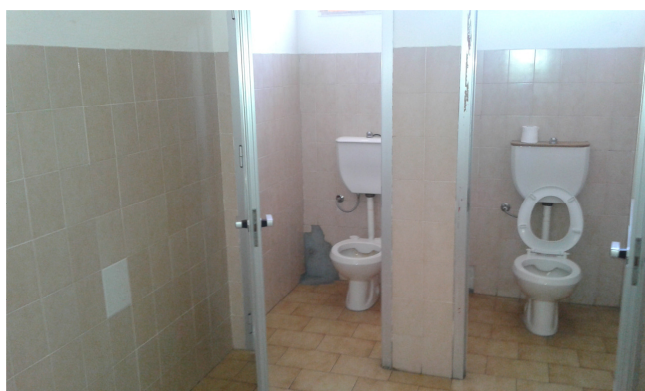
Servizio igienico al piano terra
